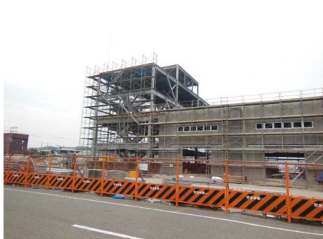
写真 5. 漁港施設の避難タワー（建設中）
