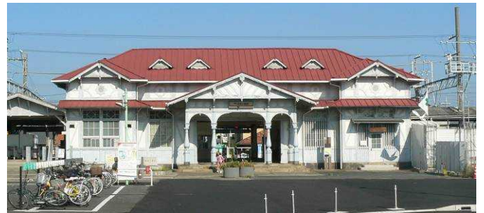
南海本線「浜寺公園駅」の駅舎
